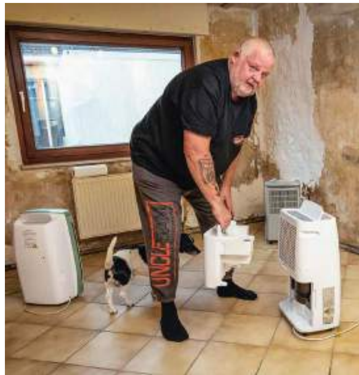
▲ Bei Hans-Jürgen Schmitz stand das Erdgeschoss komplett unter Wasser. Bautrockner sorgen dafür, dass das Haus wieder renoviert werden konnte
